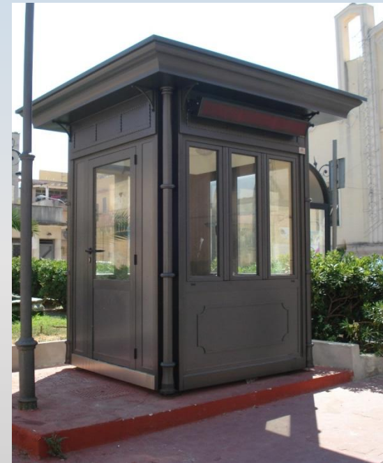
Centro di informazioni turistiche nel comune di Trappeto
